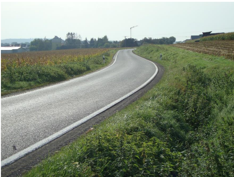
Abb. 3: Kreisstraße 297 in Blickrichtung zur Ortslage. Rechts der breite Randstreifen mit Böschung. © Planungsgruppe Prof. Seifert, Oktober 2023.
