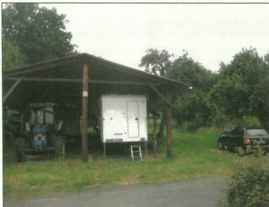
Abb. 3: Bestand Lagerhalle; © Krauß, Juli 2024
